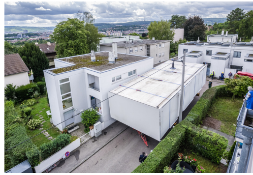
Verpackt und transportfähig: Das kompakte Aktivhaus B10 kann in kürzester Zeit ab- und wieder aufgebaut werden. 5 Jahre stand das von Werner Sobek entworfene Gebäude nun in der Stuttgarter Weißenhofsiedlung inmitten von denkmalgeschützter Bauhausarchitektur. Foto: René Müller
