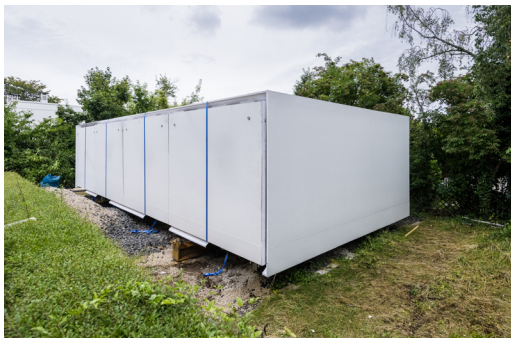
Komplett verpackt, sieht man nicht, dass sich dahinter ein innovatives Gebäude mit einem ausgeklügelten Energiemanagement verbirgt. Das von Werner Sobek geplante Aktivhaus B10 ist von der Stuttgarter Weißenhofsiedlung auf die schwäbische Alb gezogen. Foto: René Müller
