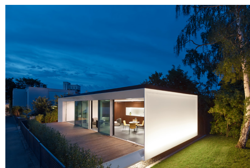
Viel Sorgfalt wurde beim Aktivhaus B10 auf ein durchdachtes, funktionales Raumkonzept gelegt sowie auf hochwertige Materialien und ausgesuchte Produkte. Die modulare Bauweise ermöglicht eine serielle Fertigung in hohen Stückzahlen und in kurzer Zeit – in Zeiten knappen Wohnraums ein wichtiger Aspekt. Foto: Zooney Braun
