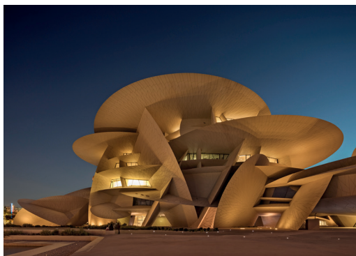
Das neue Nationalmuseum von Katar: Um diesen komplexen Entwurf in die gebaute Wirklichkeit umzusetzen, waren bei Planung und Umsetzung Höchstleistungen gefordert. Genau an dieser Nahtstelle kamen die Ingenieure von Werner Sobek ins Spiel: Die international agierende Firmengruppe mit Hauptsitz in Stuttgart hatte bereits an vielen anderen komplizierten Großprojekten in Asien, Europa und im Mittleren Osten mitgewirkt. Foto: Andreas Keller, Altdorf
