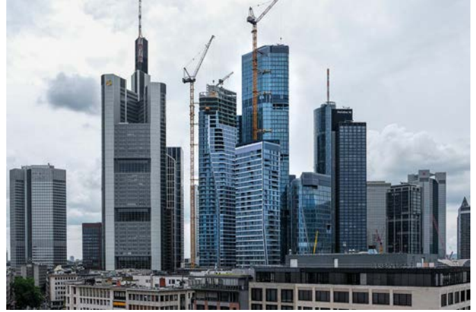
Bild 17 Die FOUR Baustelle inmitten der Skyline (Ende Mai, 2024) (Quelle: FOUR Frankfurt, webcam) The FOUR construction site in the middle of the skyline (end of May, 2024)
