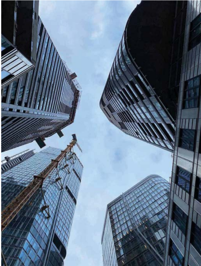
Bild 1 Baustelle FOUR (Quelle: ATW FOUR) FOUR construction site
