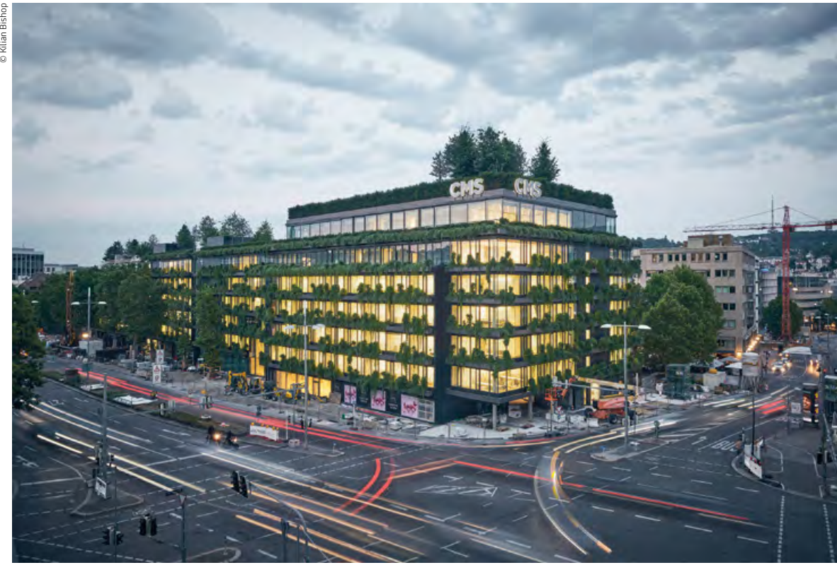
Für die Neugestaltung der „Calwer Passage“ in Stuttgart entwickelte die Werner Sobek AG ein Nachhaltigkeitskonzept mit Grünfassade. Rund 2.000 großformatige Pflanzgefäße finden in der Konstruktion, die der Glasfassade vorgelagert ist, Platz.
