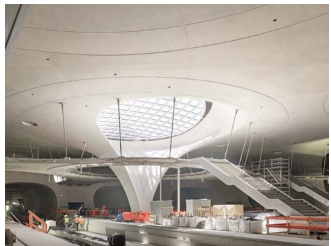
Bild 4 Ansicht des Verteilerstegs C im Bauzustand (Quelle: Achim Birnbaum, Stuttgart) View of distributor platform C during construction
