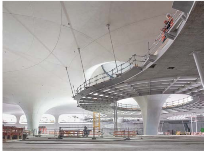
Bild 8 Vom Schalendach abgehängter Verteilersteg B mit vereinzelt schlanken Stützen auf den Bahnsteigen (Quelle: Achim Birnbaum) Suspension of distributor platform B from the shell roof with individual slim supports on the platforms in the main station
